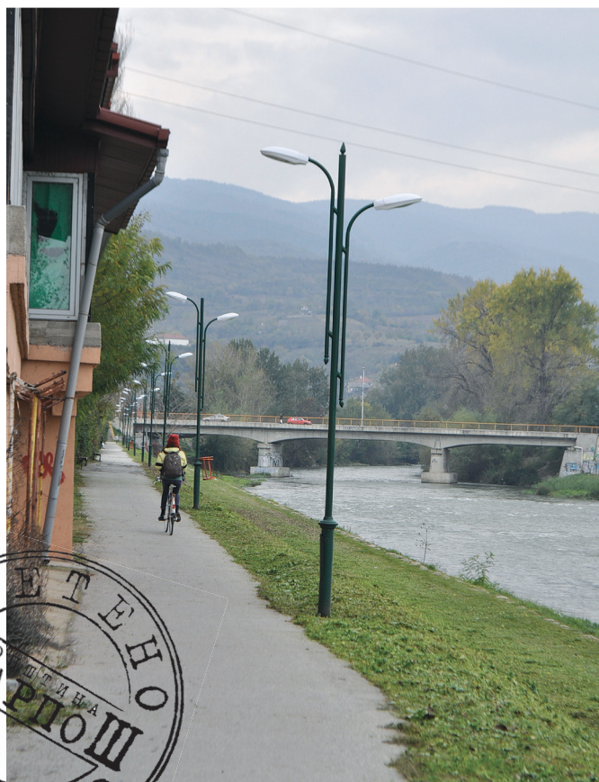
Нови 37 светлечки арматури со подобра расвета на кејот на Вардар. Изведувач: Електроизградба-Скопје
